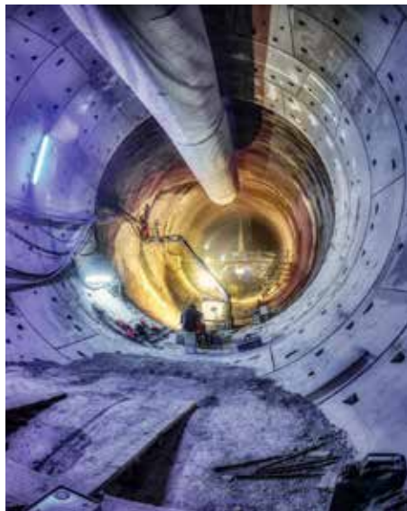
Tunnelausstellung im DB Museum: Fildertunnel, Foto © DB AG/ Armin Kilgus
